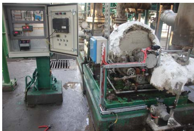
اتمام ساخت- آماده حمل جهت نصب در شرکت پالایش نفت امام خمینی (ره) شازند
